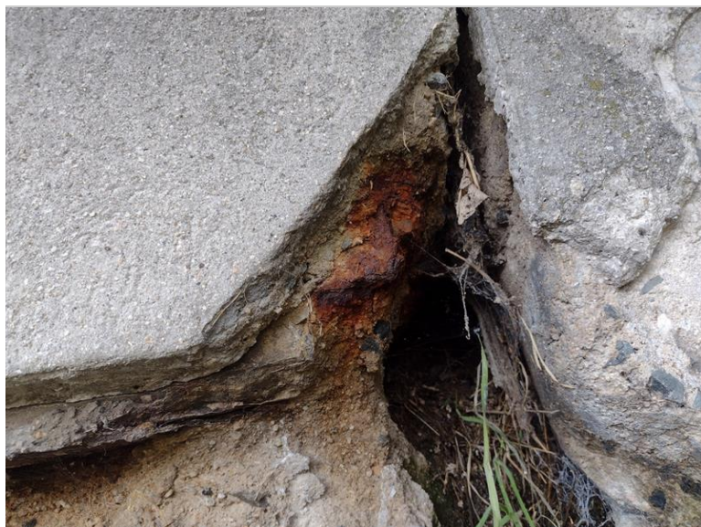
Koroze kotevní desky u OP1 vlevo
