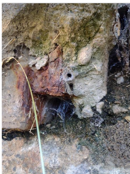
Koroze kotevní desky u OP1 vlevo
