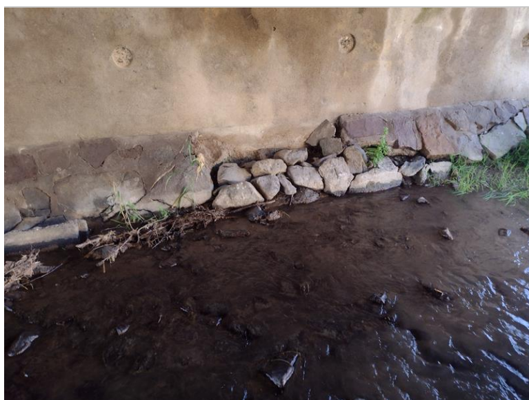
Stopy po diagnostice a rozpad odláždění paty na OP1
