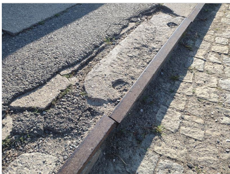
Rozpad povrchu pravého chodníku s vykloněnou ocelovou hranou obruby
