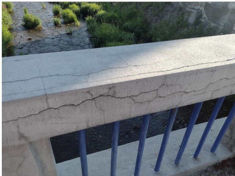
Popraskaný povrch sanace zábradlí
