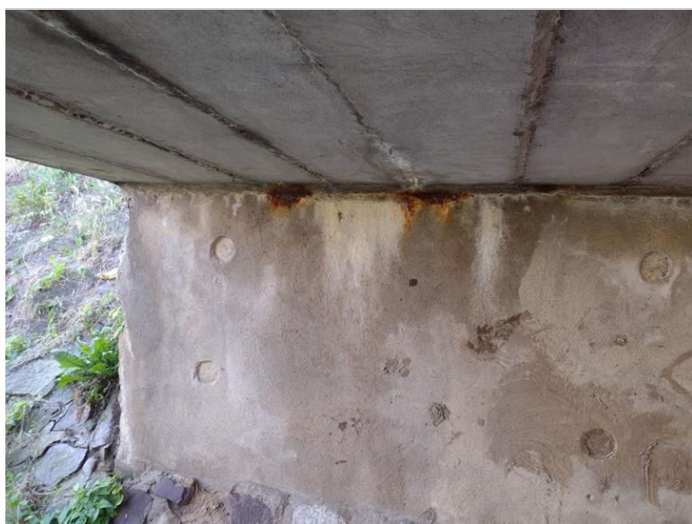
Stopy po diagnostice a zatékání na OP1
