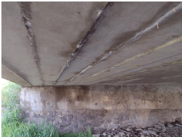
Stopy pro zatékání mezi nosníky NK
