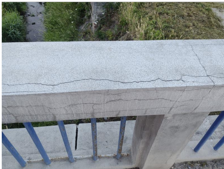
Popraskaný povrch sanace zábradlí
