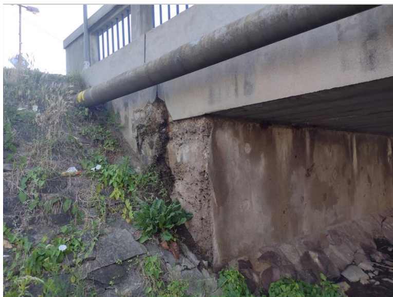
Boční pohled na OP1 - degradace OP
