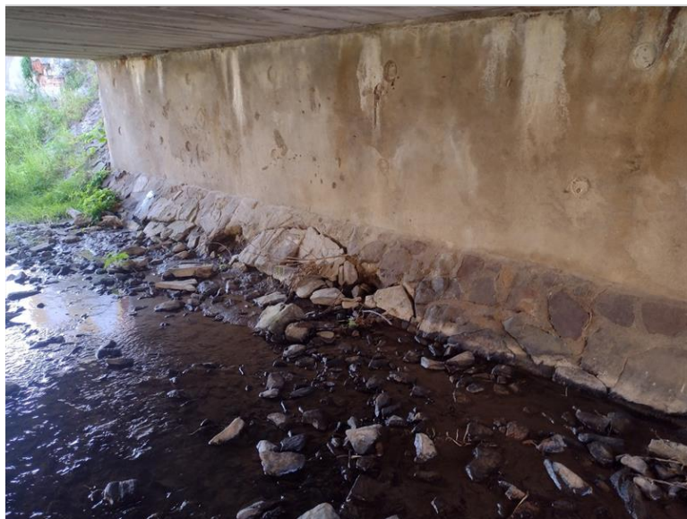
Stopy po diagnostice, stopy po zatékání a rozpad odláždění paty na OP1
