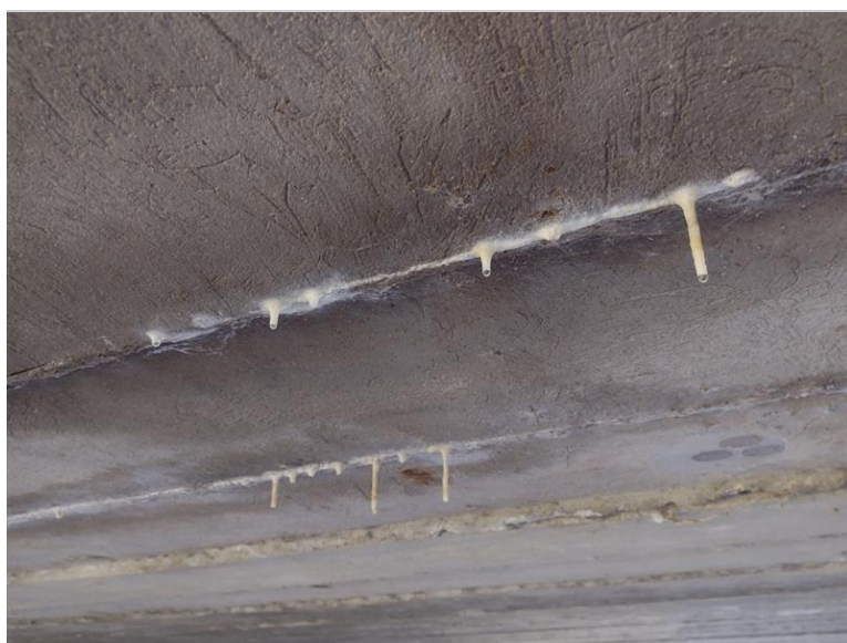
Stopy pro zatékání mezi nosníky NK
