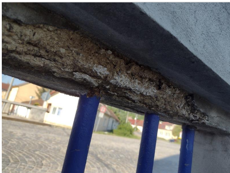
Popraskaný povrch sanace zábradlí
